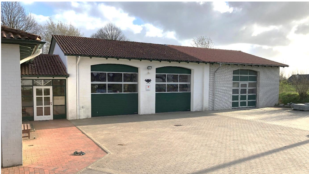
Abbildung 30: Feuerwehrgerätehaus (Quelle: eigene Aufnahme, 2021)
