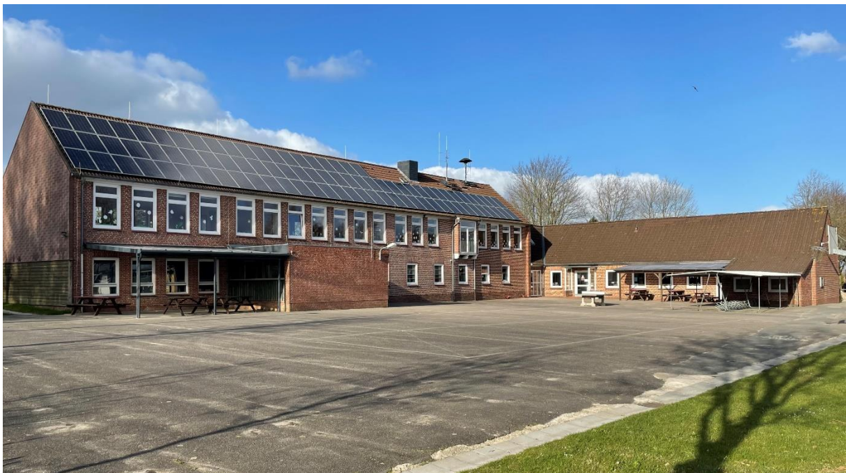
Abbildung 26: Grundschule Bergenhusen (Quelle: eigene Aufnahme, 2021)
